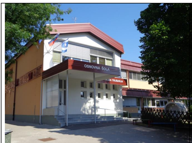
Prenovljena šolska zgradba
